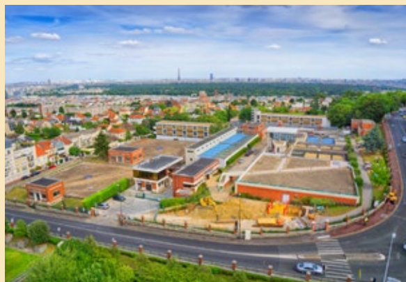
Vue aérienne du site de SENEQ © Sénéo
