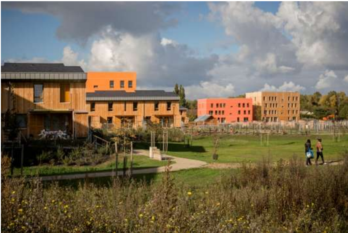
Eco-quartier des Noés, Val-de-Reuil (Eure), Atelier Philippe Madec (2010). PIERRE-YVES BRUNAUD/PICTURETANK
