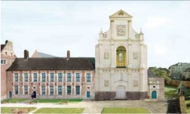
Façade du musée avec la chapelle © Pierre DEVRED
