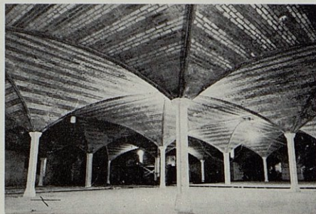
vue partielle de l'un des niveaux du pavillon XII
