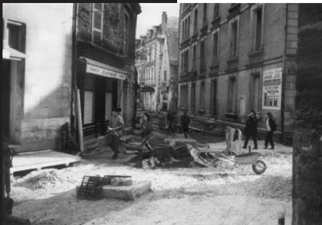
Rue Touny, pendant les travaux Tranche 4, 1993 Photographie mairie de Sarlat
