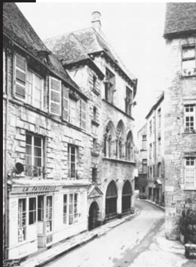
L'hôtel Plamon après restauration Photographie Guy Rivière, 1975
