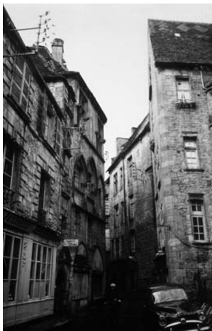
Rue des Consuls, avant travaux Photographie Guy Rivière
