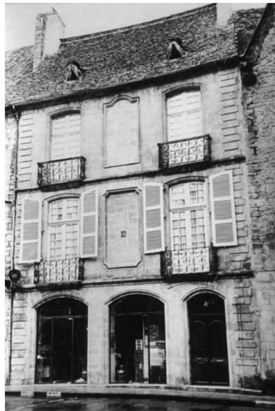
Façade après travaux
