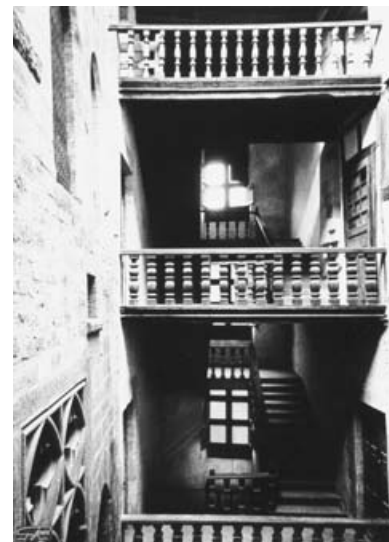
Escalier de la cour intérieure, après restauration, 1960/ 1970 Hôtel Plamon. Photographie Guy Rivière, 1960
