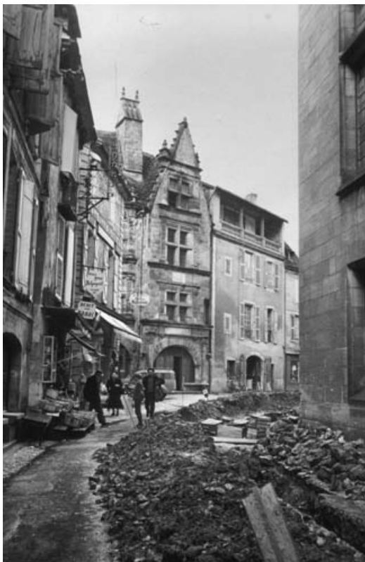
Rue Tourny pendant travaux
