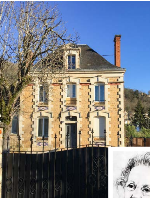
Maison de Suzanne de Béarn, avenue Aristide Briand, 2022
